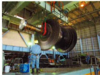
2号機低圧タービン吊り上げ
