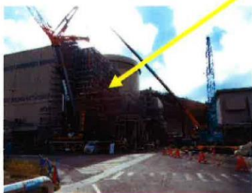
西側減築工事中
